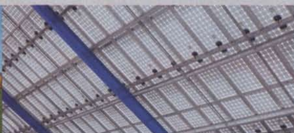
Vues extérieure et intérieure d'une toiture avec une combinaison Upsolar / Mecosun.
