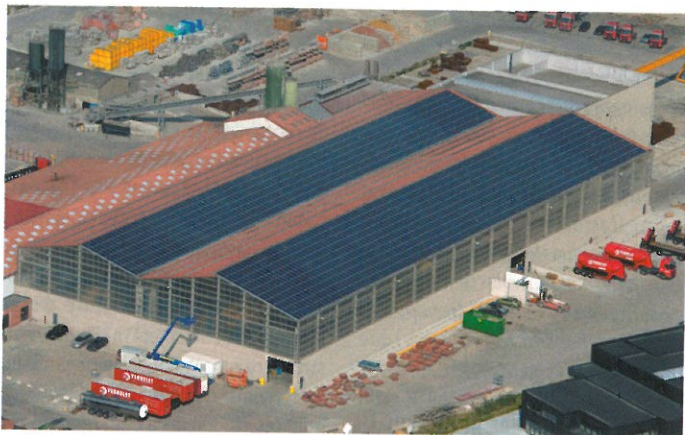
Toiture solaire Mecosun.
