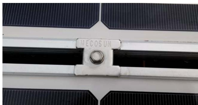
La mise à la terre des modules se fait en visant les serre-joints de fixation.
