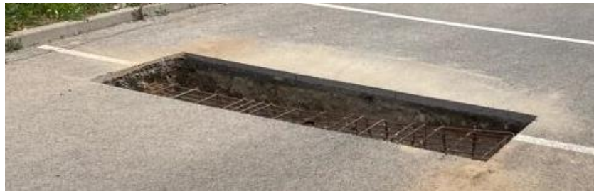
Semelle renforcée (+ ancrages)
