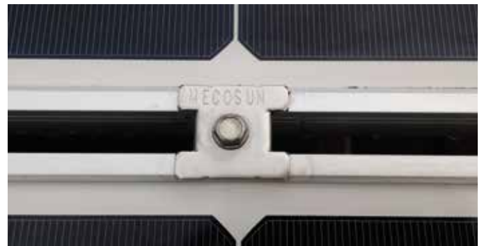
La mise à la terre des modules se fait en visant les serreurs de fixation.
